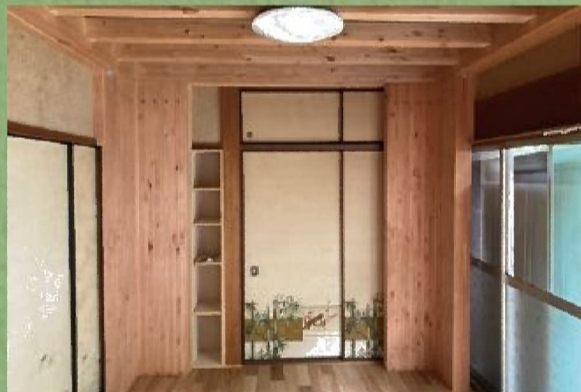
▲リビングの一部、キッチン部分のシェルター補強改修
